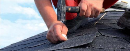
Da in unserem Beispiel die einzelnen Dachflächen bereits beschindelt sind, müssen nur noch einzelne kleine Dachpappe-Stücke an den einzelnen Dachkanten (Grat) angebracht werden
