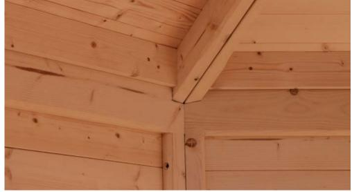
Nehmen Sie eine Schraubzwinge und ziehen Sie nun das so ausgerichtete Dachelement am Dachüberstand (Außenbereich) zusammen und verschrauben diese von links und rechts miteinander. Zum Schutz des Holzes legen Sie zwei kleine Hölzer unter die Zwinge.
