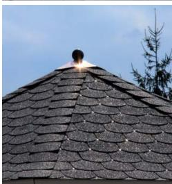
dass die Schindel beide Seiten zur Hälfte abdeckt. Nageln Sie diese mit zwei Dachpappnägeln in der oberen Hälfte der Schindel am Dach fest. Das nächste Schindelstück legen wir überhalb des bereits montierten. Platzieren Sie es so, dass die schwarze Klebefläche von der darauf liegenden Schindel überdeckt wird. Wiederholen Sie dieses, bis Sie an der Spitze angekommen sind. Vollziehen Sie diesen Arbeitsgang bei den restlichen Dachkanten (Graten) genauso.
