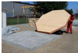
Nehmen Sie nun Schraubzwingen und fixieren Sie die Bodenteile an der zusammengesetzten Stelle und verschrauben diese mit den mitgelieferten Schrauben je nach Modell mit ca. 6 - 8 Schrauben.
