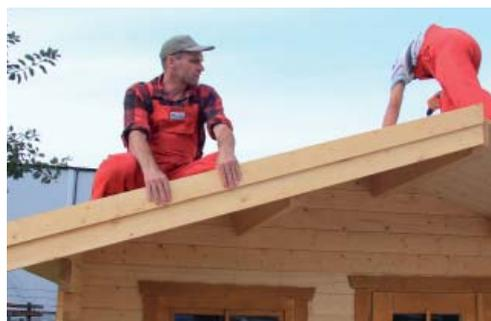
Montez ensuite les **planches du pignon** à l'avant et à l'arrière. Vissez les planches du pignon au voligeage et à la panne faîtière / la panne courante ; la distance du bord supérieur de la planche du pignon vers le bord supérieur du voligeage devrait être de 5 à 6 cm environ. *(Il est recommandé de marquer le centre de la panne faîtière avec un crayon pour éviter de dépasser involontairement le centre de la panne faîtière).*
