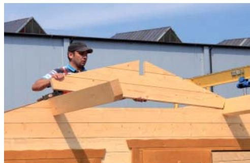
Montez les deux pannes courantes dans les évidements correspondants dans le pignon. Veillez à ce que les poutres (*pannes*) affleurent le pignon et soient dans le même angle avec ce dernier. Si nécessaire, corrigez la position à l'aide d'un marteau. Montez ensuite le deuxième (*petit*) élément du pignon entre les deux pannes courantes et sur l'élément du pignon avant déjà monté. Répétez l'opération pour le pignon arrière. Montez ensuite la panne faîtière dans les évidements supérieurs du pignon.
