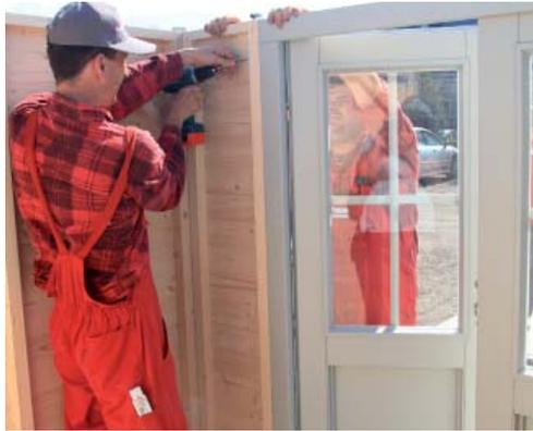
Introduisez la clé que vous avez retirée de la paroi latérale dans le barillet et vérifiez si elle fonctionne bien. Montez ensuite la porte dans la maison. Ouvrez la porte et, si nécessaire, corrigez la position de la porte également par l'intérieur. **Veillez à ce que le vantail ne s'ouvre pas de façon incontrôlée.** Vissez ensuite la porte avec ses éléments et veillez à ce que ces derniers soient montés avec précision.
