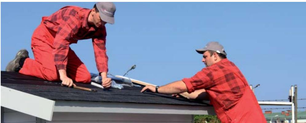
**En plus du carton bitumé, Bertsch Holzbau recommande généralement une protection supplémentaire avec bardeaux (bardeaux bitumineux disponibles en option). Ceci permet d'assurer une meilleure protection du toit et de l'ensemble de la maison.**
