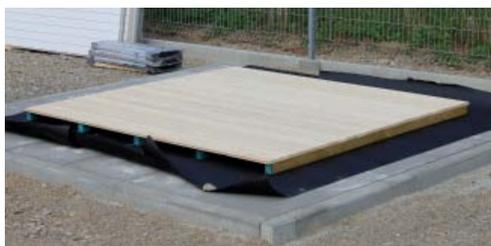
Positionnez la base pré-montée à l'endroit souhaité sur les fondations.
