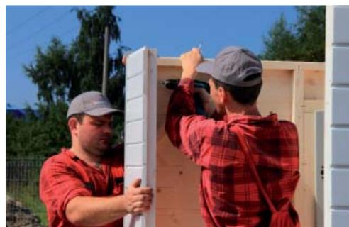
Les éléments ne doivent pas présenter des fentes et doivent s'affleurer. Il est recommandé de fixer les éléments les uns avec les autres à l'aide de serre-joints.
