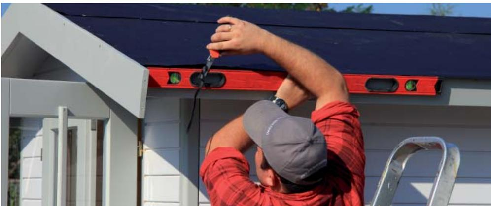
La pose se fait toujours en commençant du bas vers le haut ; la dernière couche au niveau de la crête (pointe du toit) est étalée en dernier sur les deux parties du toit. Lorsqu'un chéneau (disponible en accessoire) doit être monté, il est recommandé de faire dépasser le carton bitumé de 5 cm au niveau de la planche d'égout des eaux de pluie pour permettre à l'eau de s'écouler directement dans le chéneau.
