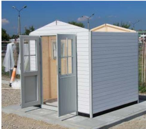
Vérifiez ensuite le bon positionnement des éléments sur le sol. Si nécessaire, corrigez leur position en poussant les éléments jusqu'à les mettre dans la bonne position. Vissez suffisamment les éléments au sol et vérifiez à nouveau le vissage des éléments de paroi.
