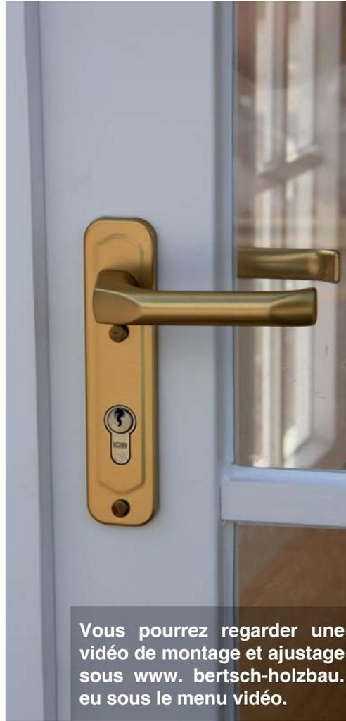
Introduisez la poignée de fenêtre dans la serrure montée dans la fenêtre. Vous pouvez serrer la vis supérieure à l'aide d'une visseuse sans fil ou un tourne-vis. Veillez à ne pas forcer la vis si vous travaillez avec une visseuse sans fil. Une fois la fenêtre ouverte, la poignée ne vous gêne plus, et vous pouvez visser la vis inférieure.
