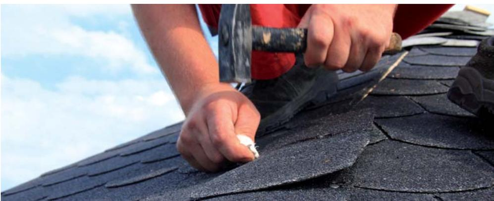
Etant donné que les bardeaux sont déjà prémontés sur les surfaces de toit individuelles dans notre exemple, il ne faut qu'appliquer des petits morceaux de carton bitumé sur les bords de toit (arêtiers).
