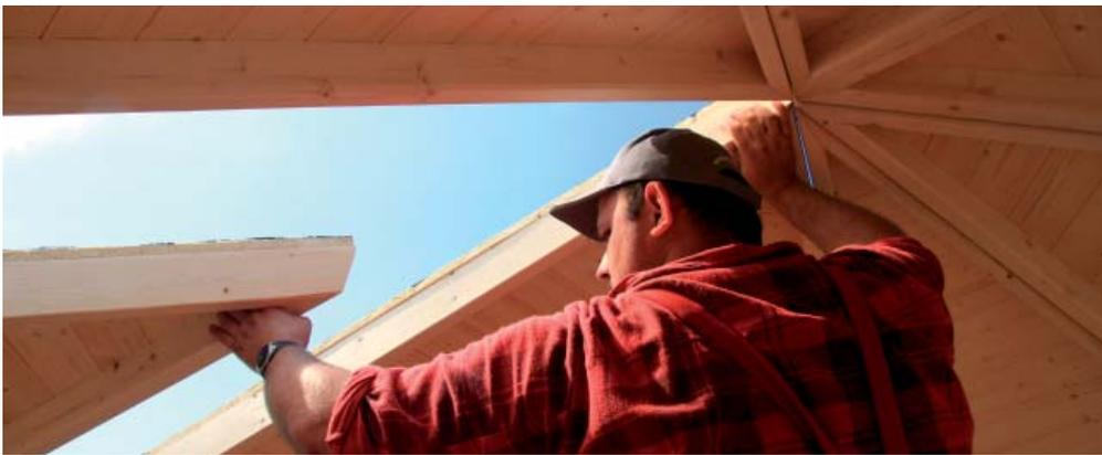
A l'aide d'un serre-joint, serrez l'élément de toit ainsi aligné à la saillie (côté extérieur) et vissez les éléments à droite et à gauche les uns avec les autres. Placez des petits morceaux de bois au-dessous du serre-joint pour protéger le bois.
