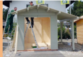
Erstellung der Dachschalung
