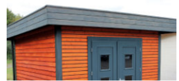
Flachdach (mit Dachüberstand)
