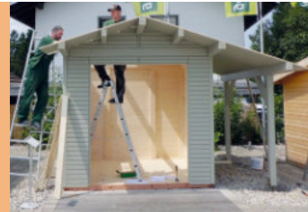
Erstellung der Dachschalung
