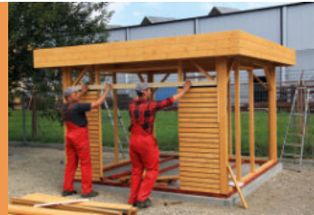
Anbringen der Rhombusschalung
