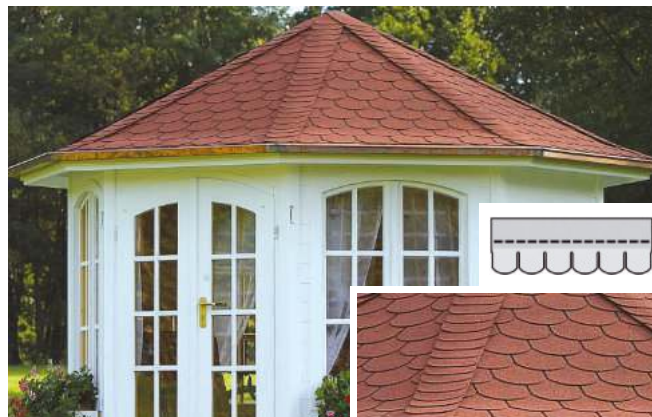
DES BARDEAUX EN „QUEUE DE CASTOR“
