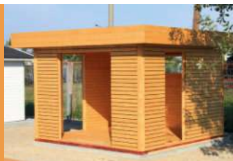
Coffrage de toit et de mur
