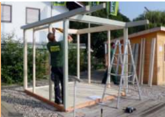
Montage de l'ossature autoporteuse
