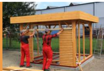
Montage du coffrage en losange
