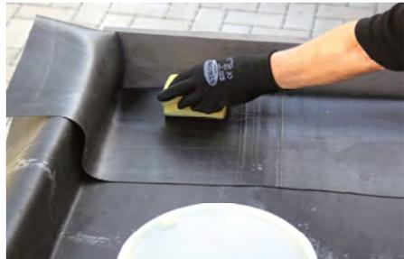
Nun die kompletten Blenden mit dem Roller abfahren und die Plane andrücken. Bei der Verklebung auf die Blenden empfiehlt es sich dünne Handschuhe zu tragen, so behalten Sie saubere Finger. Nun die Plane rundum auf Blendenhöhe mit der Schere abschneiden (Bild links unten).
